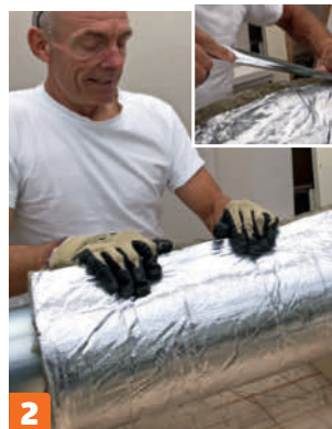
2 Taittele eristeet putkien ympärille ja teippaa eristeet yhteen alumiiniteipillä. Peitä kaikki saumat teipillä.
