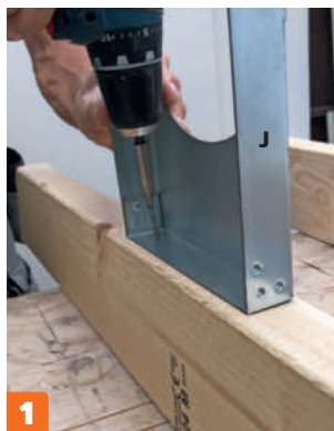
1 Ruuvaa kannattimet (J) kiinni kattoristikoihin yleisruuveilla. Varo kannattimien teräviä reunoja.
