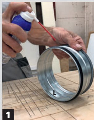
1 Suihkuta silikonilla liitoskappaleen (L) tiivisteisiin, ennen kuin painat osat yhteen.
