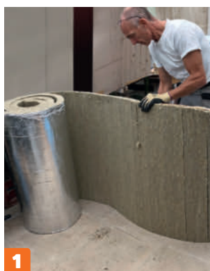
1 Leikkaa eristeet sopiviksi putkien ja muiden osien ympärille.
