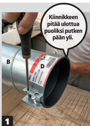
1 Ruuvaa ensimmäinen kiinnike (D) putken (B) päähän.
