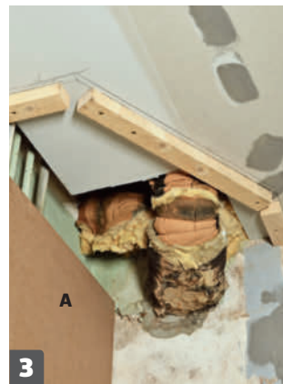
3 Kiinnitä asennuslistat. Piirrä yläsokkelin muoto kattoon ja kiinnitä kolme asennusrimaa 5,0x60 millin ruuveilla.
