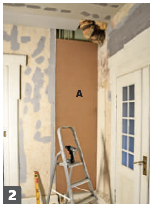
2 Ruuvaa peitelevy (A) kiinni 4,0x40 millin ruuveilla.
