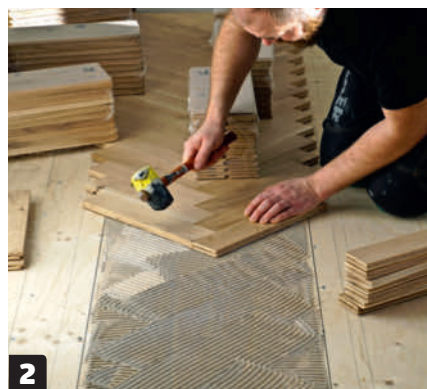
2 Varmista, että sauvojen kärki pysyy keskiliinan kohdalla. Tarkkaile koko ajan, että pontit painuvat kokonaan kiinni. Voit lyödä saumat kiinni, mutta ole varovainen, sillä liian kova isku voi pilata koko rivin.
