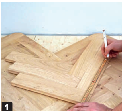
1 Yhdistä laudat väliaikaisesti kolmioksi, joka täyttää seinän vieressä olevan tilan. Älä liimaa lautoja yhteen vielä tässä vaiheessa.
