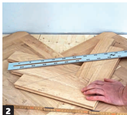
2 Mittaa kolmio ja piirrä mitat lautoihin. Sahaa laudat sirkkelillä.
