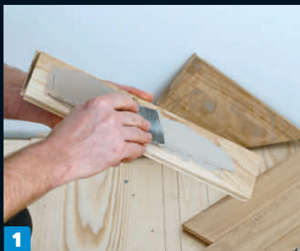
1 Aloita levittämällä liimaa 3–4 lautaan. Varmista, että laudat painuvat kunnolla kiinni toisiinsa ja ensimmäisen rivin lautoihin. Koputa laudat varovasti paikalleen vasaralla.
