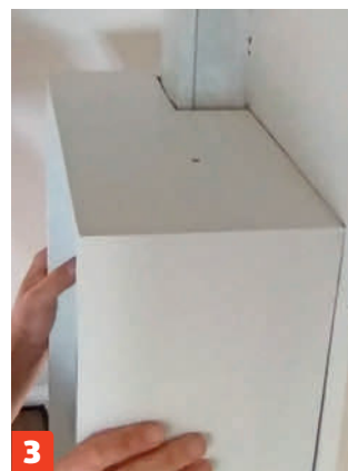
3 Nosta kaappi paikalleen riman (E) varaan. Asenna lopuksi ovi.
