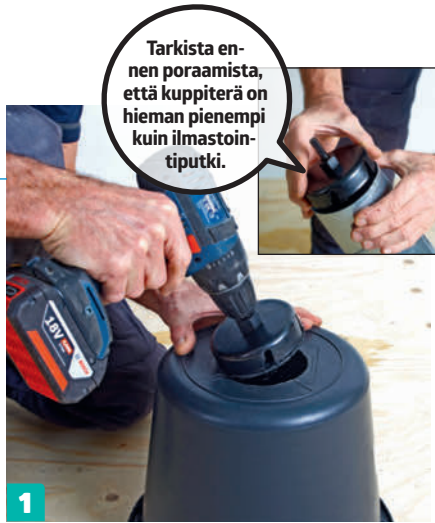
1 Poraa reikä paljon keskelle. Kuppiterän pitää olla pari milliiä pienempi kuin ilmastointiputken, joka työnnetään reikään.
