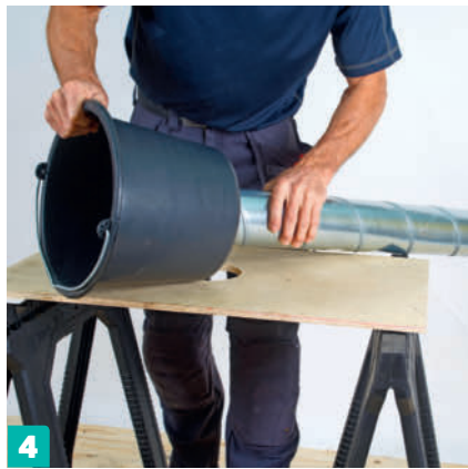
4 Työnnä putki paljon pohjan läpi. Putken pitää yltää noin 9–10 senttiä paljon puolelle, jotta betoni tarttuu kunnolla kiinni putkeen.
