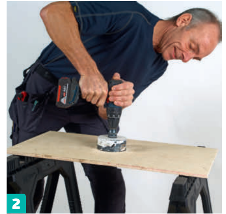
2 Poraa tai sahaa puulevyyn reikä. Nosta levy parin pukin varaan. Reiän pitää olla hieman putkea isompi.
