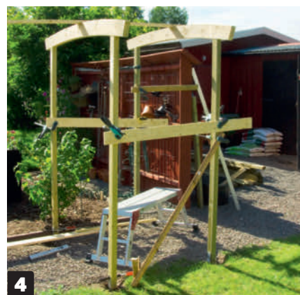
4 Pystytä seuraava tolppapari. Kiinnitä tolpat väliaikaisesti ensimmäisiin tolppiin parilla laudalla ja puristimilla.
