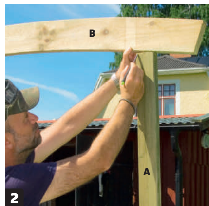
2 Asenna poikkipuut (B) tolppien (A) päälle ja piirrä kaaren muoto tolppiin. Varmista, että tolppa on pystysuorassa, kiinnitä se väliaikaisesti lautaan ja sahaa tolpan pää viivaa pitkin.
