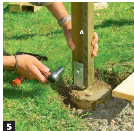
5 Ruuvaa tolpat (A) kiinni pilarikenkiin kansiruuveilla eli täkkipulteilla. Poraa ruuvinreiät valmiiksi. Ruuvaa pari ruuvia myös tolpan toiselle puolelle.
