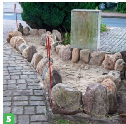
5 Alin rivi on nyt asennettu. Varmista, että kaikki kivet ovat kunnolla kiinni asennushiekassa, jotta ne pysyvät paikallaan, kun seuraavat kivet asennetaan niiden päälle.
