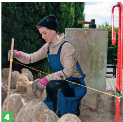
4 Tarkista korkeus linjalangalla. Mittaa kiven ja langan välinen etäisyys ja asenna kivet siten, että lankaan on joka paikasta suunnilleen yhtä pitkä matka.
