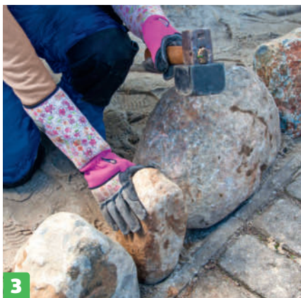
3 Asenna alimmat kivet. Valikoi alimpaan riviin kaikkein isoimmat kivet. Lyö kivet kunnolla kiinni hiekkaan kumivasaralla.
