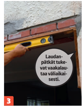
Kiinnitä lauta tiilipalkin alle. Ruuvaa lauta kiinni tiilipalkin saumoihin. Tue vaakalaudan päät laudanpätkillä.
