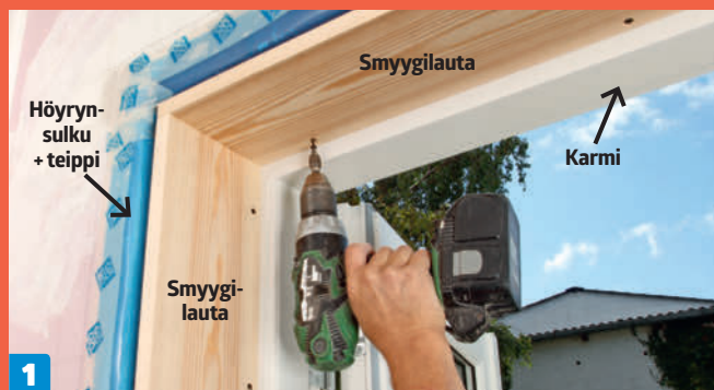
Asenna smyygilaudat varovasti, jotta höyrynsulkuun ei tule tarpeettomia reikiä. Paina smyygilautaa karmia vasten samalla, kun ruuvaat laudan kiinni 35 millin kipsilevyruuveilla. Ruuveissa on kärki, joka porautuu smyygilaudan takana olevan alumiinilevyn läpi.
