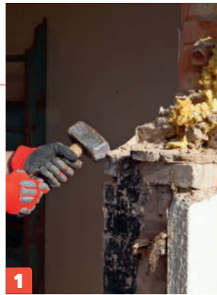
Lyö reunatiilet irti moskalla ja irrota tiilet seinästä.
