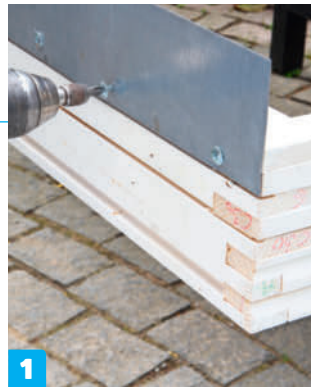
Ruuvaa alumiinilevyt karmiin. Kiinnitä levyt sivu- ja yläkarmiin. Käytä leikkaamiseen peltisaksia. Ruuvaa pellit kiinni 14 millin levyruuveilla.
