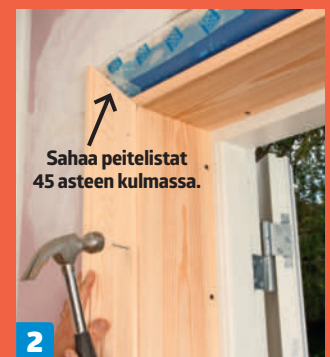
Naulaa peitelistat kiinni smyygilautoihin 1,8 x 35 millin viimeistelynauloilla viisi millia listan reunasta.
