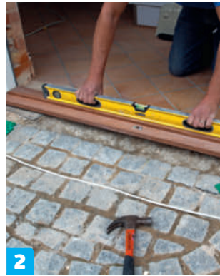
Nosta karmi paikalleen. Työnnä kynnyksen molempien päiden alle muovikiilat. Säädä kiiloja, kunnes kynnyks on vaakatasossa.
