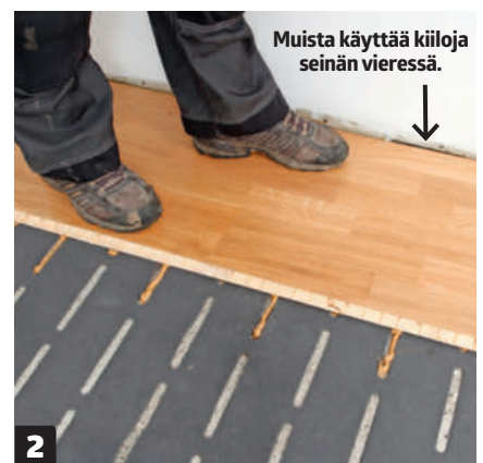
2 Asenna kaksi ensimmäistä riviä seinän viereen kiilojen avulla. Kävele lautojen päällä lyhyin askelin, jotta laudat tarttuvat varmasti kiinni liimaan. Paina laudat kiinni lattiaan aina kahden rivin välein.
