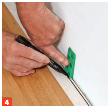
4 Liimaa teippi parketin takareunaan ja paina parketti kiinni seinään. Jäljennä seinän muodot teippiin tussin ja kiilan avulla.
