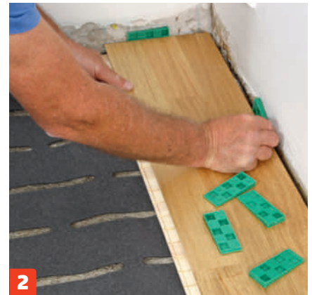
2 Jätä parketin ja seinän väliin vähintään sentin levyinen rako. Jätä tilaa myös muiden rakenteiden kuten putkien ympärille. Rako on helppo säätää sopivaksi muovikiiloilla.
