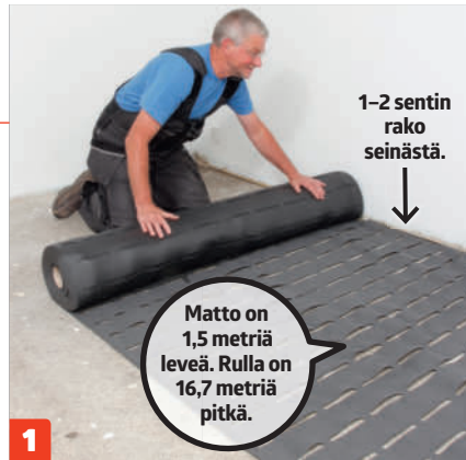
1 Levitä ensimmäinen mattokaistale. Jätä maton ja seinän väliin parin sentin rako. Levitä matto lattialautojen suuntaisesti.
