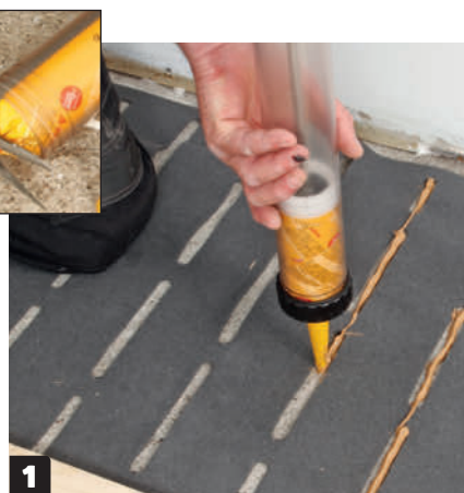
1 Levitä liimaa puolen metrin matkalle. Pidä liimapistoolia pystyssä. Pidä laudat maton vieressä ylösalaisin käännettyinä ja käännä ne nopeasti oikein päin liiman päälle.
