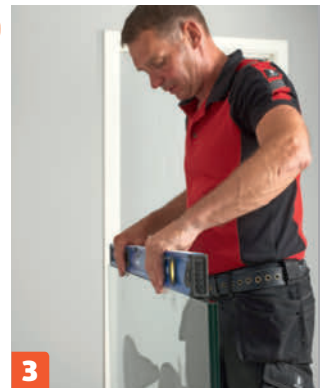
3 Tarkista, että lasi on vaaka-suorassa. Jos lasi ei ole aivan suorassa, voit nostaa sitä toisesta päästä muovikiilalla.
