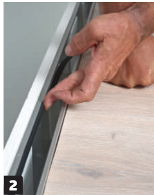
2 Paina litteä kumilista paikalleen. Se kuuluu kiilojen päällä olevaan uraan.
