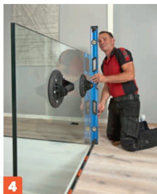
4 Tarkista, että lasi on pysty-suorassa. Voit tarvittaessa hienosäätää lasia työntämällä ohuen kiilan kiskoon ja oranssin kiilan väliin.
