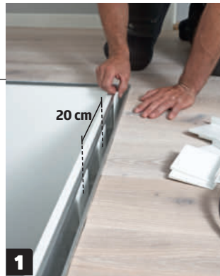
1 Asenna kiilat paikoilleen 20 sentin välein. Jätä kiskon päähän ja lasien saumoihin viisi senttiä tyhjää tilaa.
