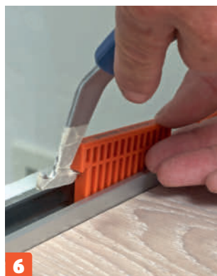
6 Voit siirtää kiilaa työkalulla. Kiilan toisessa päässä on väkänä, josta saa otteen.
