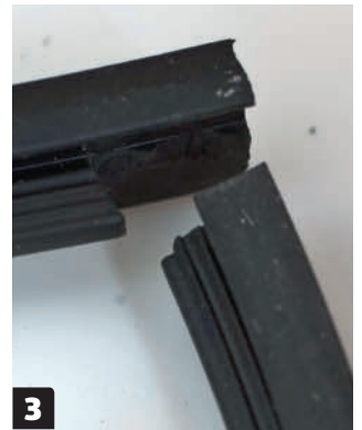
3 Kokoa kumilistat. Leikkaa listat nurkissa kuten kuvassa, jotta listat eivät limity ja aiheuta ongelmia.
