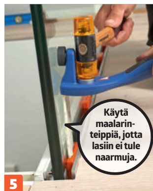
5 Lyö kiilat perille asti kaiteiden mukana tulevilla työkaluilla. Ole varovainen!
