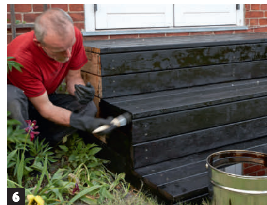
6 Maalaa portaat, kun peitelaudat ovat paikallaan ja tolpat (D) peitossa.
