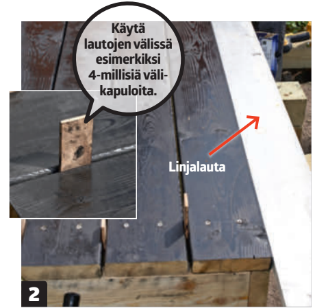
2 Ruuvaa yläportaan laudat kiinni molemmista päistä. Varmista uloimman laudan suoruus, ennen kuin kiinnität sen keskeltä. Voit käyttää apuna linjalautaa.
