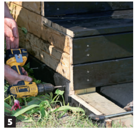
5 Sahaa ja asenna viimeiset peitelaudat. Laudat on maalattu etukäteen, sillä ne ovat osittain maan pinnan alapuolella.
