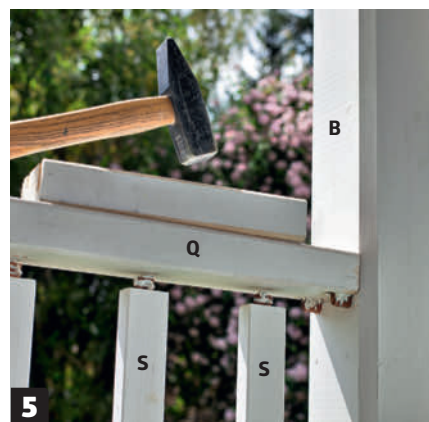
5 Asenna ylemmät vaakalankut (Q, R ja P) kiinni rimoihin (S). Asenna lankku tappeihin koputtamalla lankkua varovasti vasaralla. Käytä lankun ja vasaran välissä lyönti- kapulaa.
