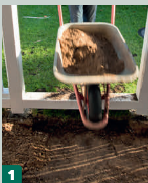
1 Poista pinnasta noin 10 sentin kerros multaa ja kärrää se pois. Lapioi tilalle mursketta.
