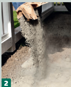
2 Kaada sementtiä murskeen pintaan. Tasoita murske sitä ennen tasaiseksi kerrokseksi esimerkiksi lapiolla.
