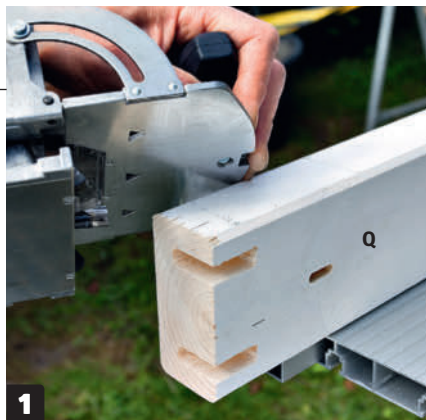
1 Sahaa kaiteiden vaakalankut (P, Q ja R) ja tee niihin tapinreiät. Tapit pitävät kaiteet kiinni tolpissa todella lujasti.
