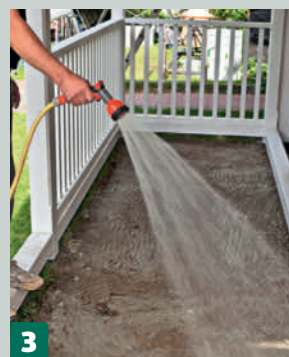
3 Kastele pintakerros, jotta sementti kovettuu. Se estää kaikenlaisten rikkaruohojen juurtumisen.
