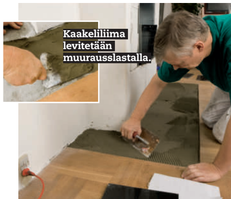
Liiman levittämisen jälkeen kaikki kaakelit on saatava paikalleen alle 30 minuutissa.
