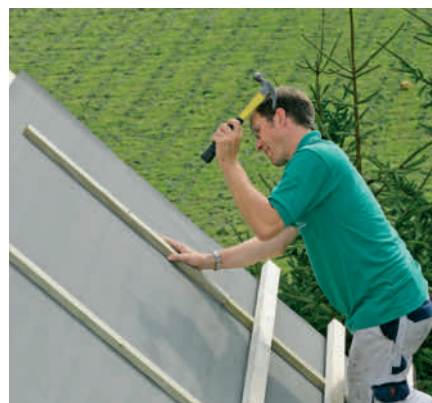
5 Paineekyllästetyt rimat naulataan pystysuoraan ennen kuin ruodelaudat asennetaan paikoilleen. Rimoilla saadaan ruoteiden ja alusrakenteen väliin tarvittava tuuletus.
