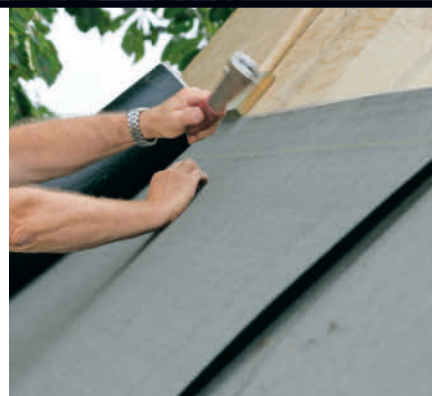
2 Yläreuna kiinnitetään niittipistoolilla tai hakasnaulaimella, kuten tässä.
