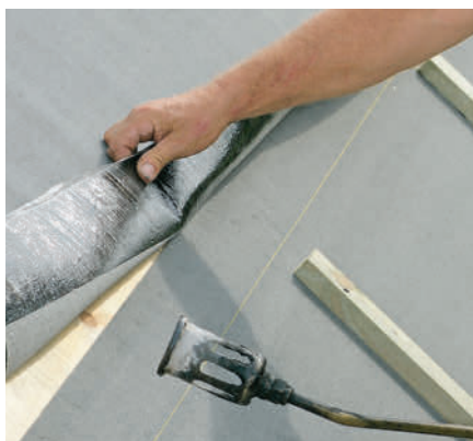
4 10 senttiä päällekkäin menevät saumat lämmitetään kaasupolttimella, jotta ne saadaan kiinnittymään alempaan vuotaan. Liimaus tukkii myös hakasnaulaimen katteeseen tekemät reiät.
