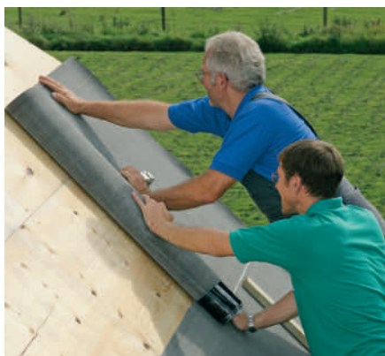
3 Heikki asettelee aluskatevuodot reilusti päällekkäin ja huolehtii saumauksesta myös ylöspäin.
