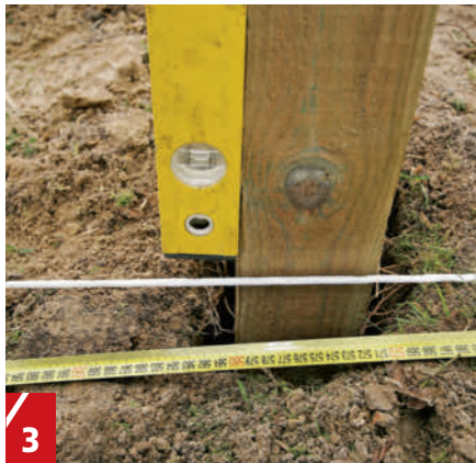
3 Toisen tolpan sijoittamisen jälkeen molemmat nurkkatolpat ovat linjassa talon kanssa. Linjanaru osoittaa oikean paikan. Välimatka 1. tolppaan mitataan 580 cm:iin ja tolpat nostetaan pystyyn. Niiden on oltava yhtä korkealla.
