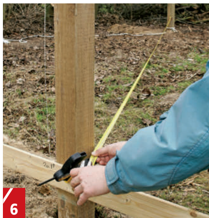
6 Lopuksi tarkistetaan, että poikittaismitat tolppaparien välillä ovat tarkalleen samat, muussa tapauksessa autokatoksesta tulee vino. Neljä viimeistä tolppaa jaetaan tasaisesti kahdelle seinustalle.
