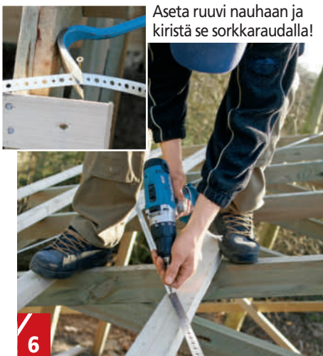
6 Vannenuha asennetaan ristikkäin kattopintoihin. Nauha ruuvataan yhteen nurkkaan ja vedetään esimerkiksi sorkkaraudalla vastakaiseen pätyyn ja ruuvataan kiinni ruodelautoihin niin moneen paikkaan kuin mahdollista.
