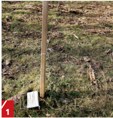
1 Ensin merkitään julkisivun paikka kahdella paalulla ja linjalangalla. Julkisivun on oltava täysin samansuuntainen talon kanssa.
