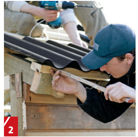
2 Rivi kattolevyjä asetetaan paikalleen mittojen varmistamiseksi. B7-levyjen tulee ulottua 6 cm alimman laudan yli, jotta ne sopivat vesikouruihin. Tarkistamme samalla 3-4-5-sääntöä käyttäen, että pinnat ovat oikeassa kulmassa.
