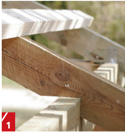
1 Ruodelaudat (E) jaetaan kattoparsien päälle ja ruuvataan väliaikaisesti kiinni mahdollisella korjausvaralla. Käytimme 6 x 80 millin ruuveja.
