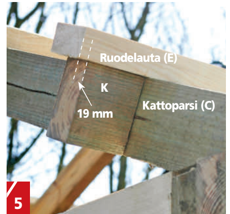
5 Jokaisen ruodelaudan alle ruuvataan pätkä palkkipuuta (K), joka muodostaa tuulilaudan (H) kiinnityksen. Kappale on 19 mm lyhyempi kuin laudan uloke, jolloin seuraava lauta voi levätä ensimmäisen päällä laudan päässä.
