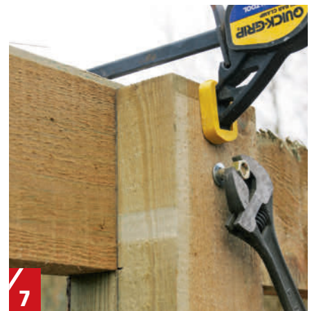
7 Orret (B) asennetaan tolppien loveuksiin. Loveus on 50 mm leveä kuten orsikin, mutta vain 120 mm korkea, jolloin 5 mm korkeampi orsi kannattelee kattotuoleja tolppien sijaan.
