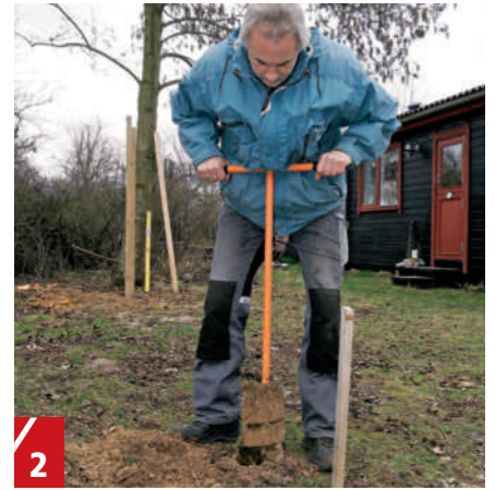
2 Aukot ensimmäisille nurkkatolpille (A) isketään juntalla. Aukko painuu helposti noin metrin syvyyteen hiekassa ja lisää uskoamme siihen, että rakentaminen yksinkertaisilla välineillä onnistuu.
