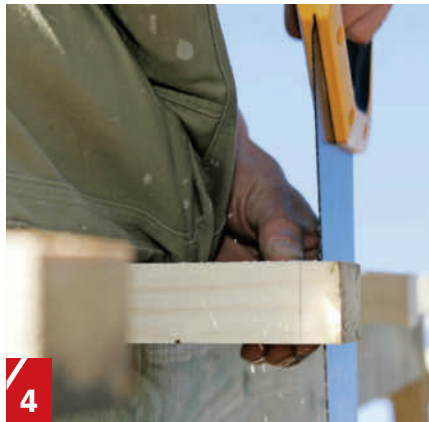
4 Ruodelaudat sahataan päistään. Myös niissä kannattaa pingottaa lanka uloimpien lautojen väliin sahaamisen helpottamiseksi. Samalla räystästä voidaan sovittaa kattolevyihin. Koeasennuksessa päätetään lopullinen leveys.
