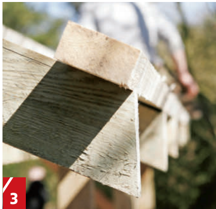
3 Kattopalkit sahataan päädyistä pystysuoriksi, jotta räystäslaudat saadaan pystysuoraan. Ulommaisten palkkien väliin voidaan vetää linjalanka, jotta päädyt saadaan sahattua suoraan.
