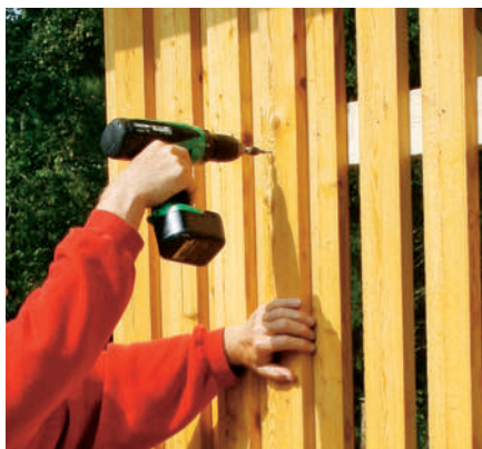
Ikkunan (ja oven) sivuille asennetaan halkaistut 25 x 50 mm:n laudat tukemaan uloimpia lautoja.
