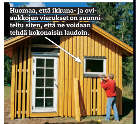
Ikkunan (ja oven) sivuille asennetaan halkaistut 25 x 50 mm:n laudat tukemaan uloimpia lautoja.
