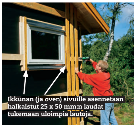
Huomaa, että ikkuna- ja ovi-aukkojen vierukset on suunniteltu siten, että ne voidaan tehdä kokonaisina laudoin.
