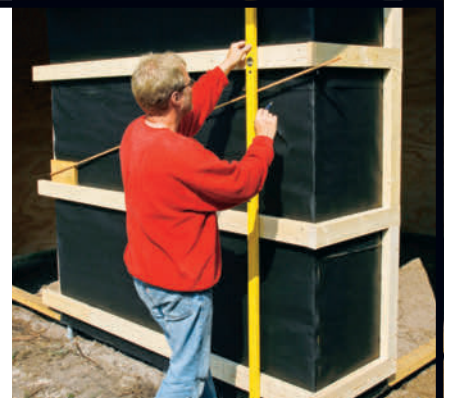
Pidä vesivaakaa mittariman merkkien kohdalla ja tee merkinnät alimpaan ja kolmanteen poikkipuuhun.
