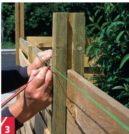
3 Aitalinjan päihin paalujen väliin pingotetaan linjalanka ylimmän laudan yläreunan korkeudelle. Paaluihin vedetään merkkilinjat langan kohdalle.
