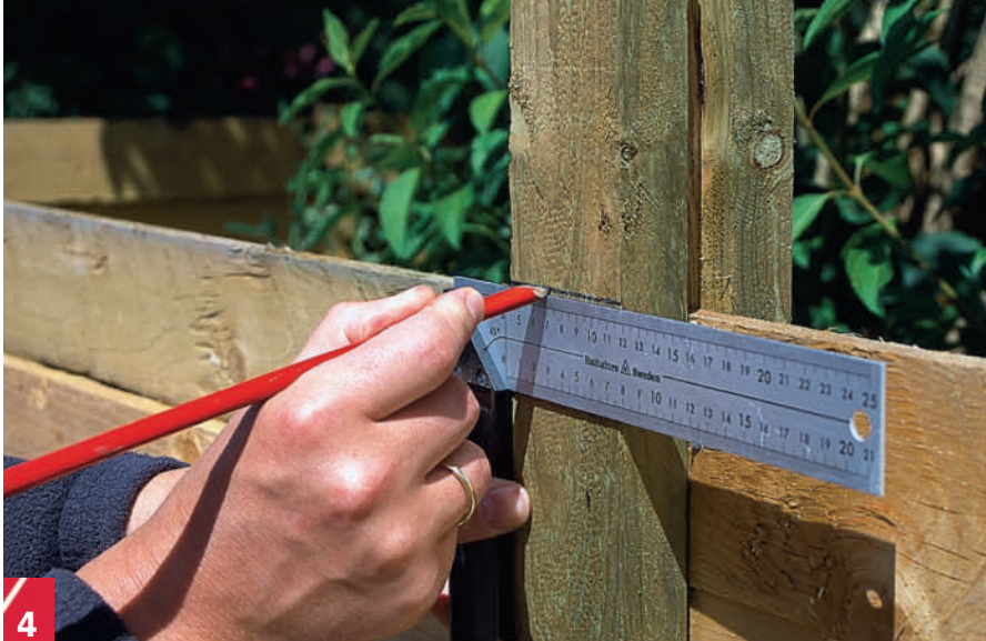
4 Paalujen katkaisulinjat vedetään suorakulman avulla. Katkaisulinjan korkeuden määrittämisessä täytyy ottaa huomioon se, että paalujen päät katkaistaan hieman vinoon.
