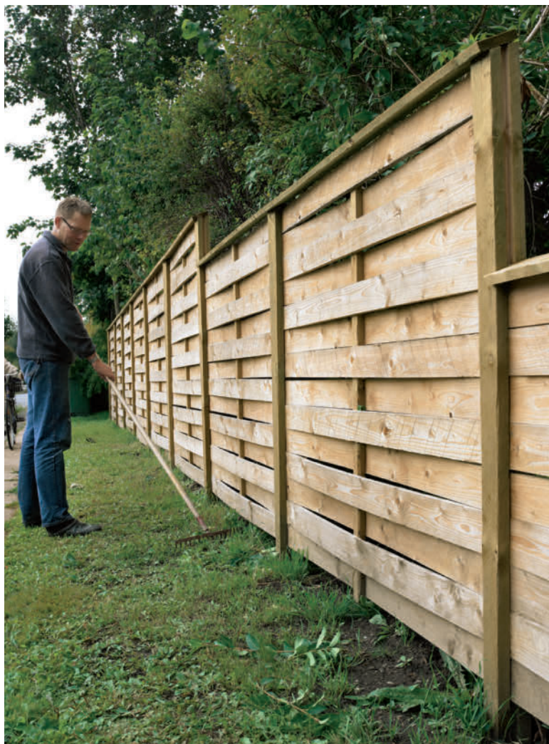
Aidan korkeus muuttuu kaltevassa paikassa, kun laudat pidetään vaakasuorassa. Säleikkö on tiivis näkösuoja, mutta päästää kuitenkin ilman virtaamaan lautojen lomasta. Myrskytuuli ei puhalla tätä suojaseinää nurin.
