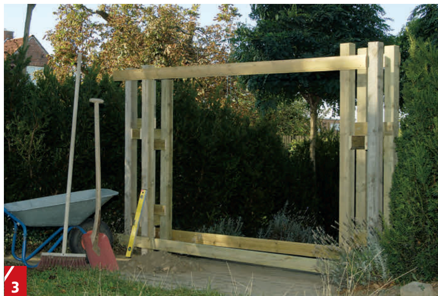
3 Pylväät säädetään samaan linjaan esimerkiksi kiinnittämällä puristimilla niiden väliin muutama lauta. Betoniin kaadetaan hieman vettä ja kuoppa täytetään hiekalla, joka tiivistetään.
