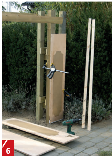
6 Peitelevyt kiinnitettiin pylväiden runkoihin ruostumattomilla 60 mm yleisruuveilla. Runkopuiden yläpäätkatkaistaan samaan tasoon peitelevyjen yläreunan kanssa.
