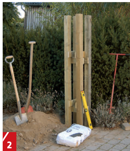
2 Pylväille tehtiin maakairalla ja lapiolla 80 cm syvät kuopat. Pylvään juurelle valettiin kuivabetonia ja kuoppa täytettiin hiekalla. Ratkaisu sopii vain routimattomaan maahan.
