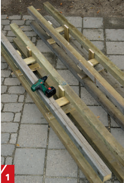
1 Pilarin runkorimat yhdistetään toisiinsa 300 mm pitkillä laudanpätkillä (B). Osat kiinnitettiin 60 mm yleisruuveilla.
