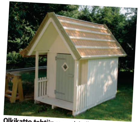
Olkikatto tehtiin samanlaiselle aluskatteelle (vaneria) kuin huopakatot on tapana tehdä. Oljet voi toki levittää pelkille orsillekin.
