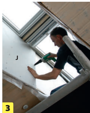
3 Ruuvaa kipsilevyt (J) runkoon kipsiruuveilla. Työnnä levyt ikkunan karmissa olevan uran pohjaan asti. Nyt levyt pitää enää tasoittaa, saumata, maalata ja yhdistää sisäkattoon.
