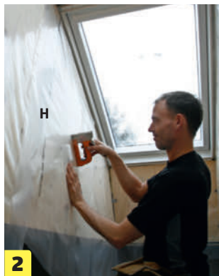
2 Niittaa höyrynsulkumuovi (H) kiinni vanerilevyyn (G).
