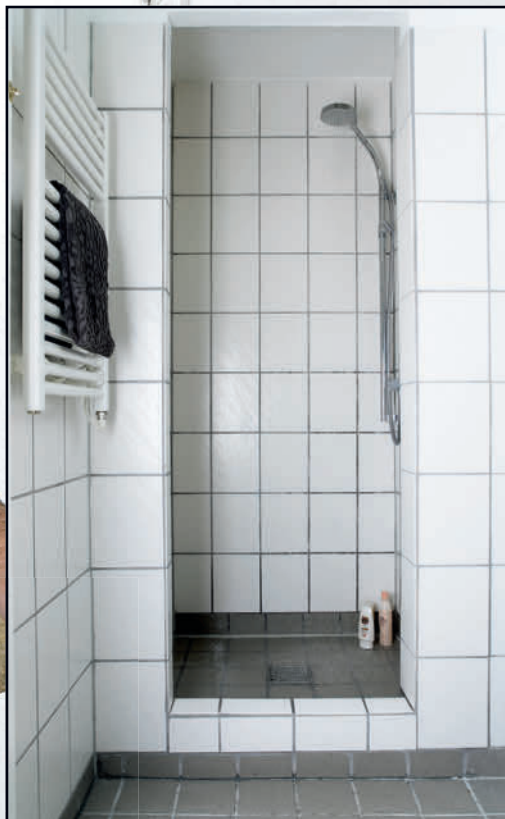
Uusi suihkukomero on rakennettu valetun betoniperustan päälle kevytbetonilaatoista. Suihkussa käyntiin on nyt tilaa.
