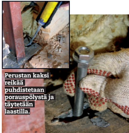
Pilarin reikien läpi porataan 12 mm:n poranterällä.
