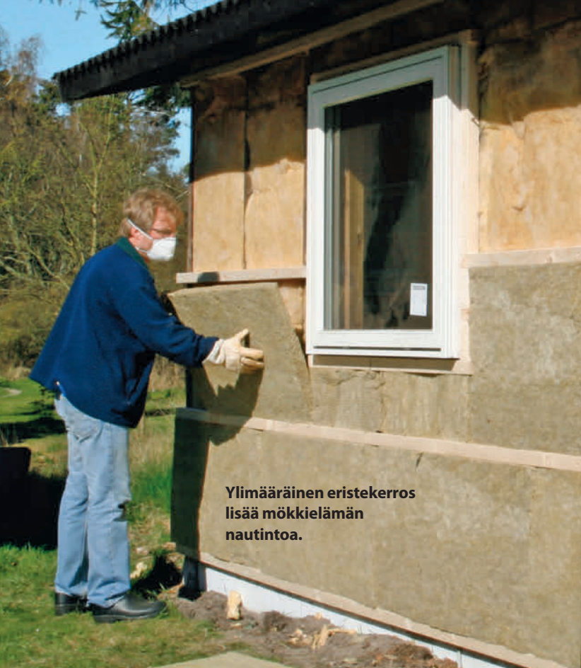
Kun lisäeristeet ovat paikallaan, mökki verhoillaan uusin laudoin. Mökistä tulee kuin uusi.
