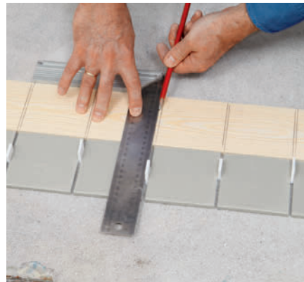
Listat A ja B muodostavat ensimmäisen kentän (1), joka laatoitetaan.
