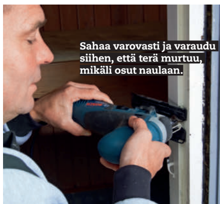
3 Sahaa karmin pistosahalla tai puukkosahalla osiin. Sahaa viistoon, jotta osat voidaan iskeä toisistaan irti. Sahaa useammasta kohdasta, niin karmin purku helpottuu.
