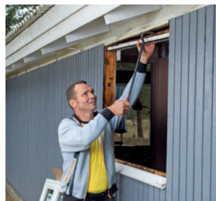
5 Varo päätä. Karmin ylintä vaakapalkkia pitää pidellä toisella kädellä, kun sitä irrotetaan. Muussa tapauksessa palkki voi pudota päähän.
