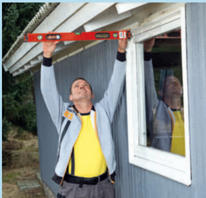
Pidä vesivaakaa paikallaan ja tarkista, että uusi ikkuna tai ovi saadaan aukaistua.
