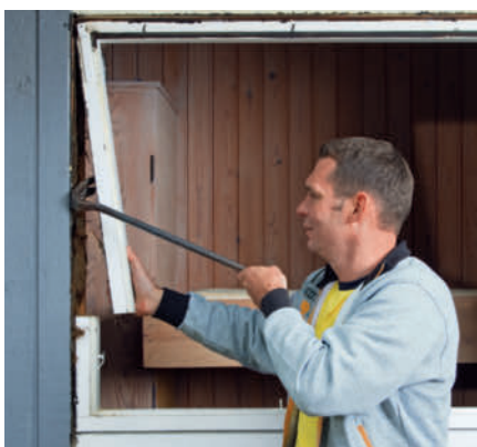
4 Käytä jälleen sorkkarautaa vääntääksesi karmin irti seinästä. Joskus karmit on kiinnitetty hyvin pitkilläkin nautoilla. Siksi sorkkaraudan alle kannattaa laittaa kiilapala, jotta sorkkarautaan saa kunnolla vääntöä.
