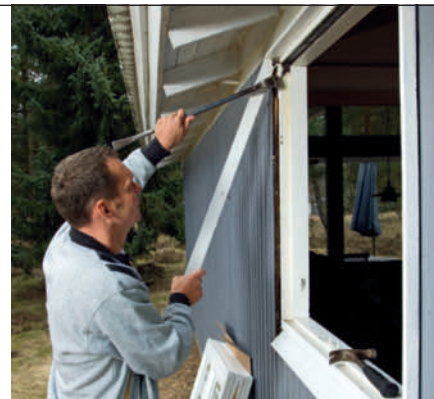
2 Poista ikkunan vuorilaudat. Työ on helpointa tehdä sorkkaraudalla, joka työnnetään ikkunakarmin ja vuorilaudan väliin.
