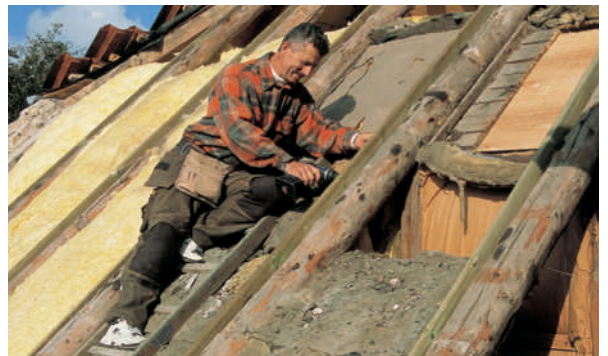
Kiinnitä kolme apunarua halutulle tasolle. Pane lankut naruja vasten ja ruuvaa ne palkkeihin kiinni.
