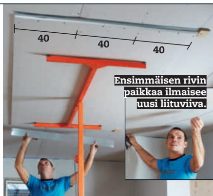
Teräsnauha kiinnitetään teräkseen tarkoitetuilla 35 mm kipsiruuveilla 25 cm välein.
