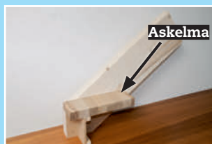
4 1. askelman liimaus ja ruuvi-kiinnitys reisi-lankkuun.
