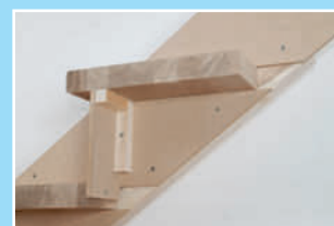
9 Jatka tähän tapaan välipohjaan asti.
