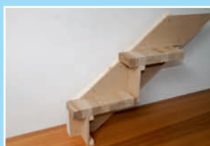
8 Sivulevy liimataan ja kiinnitetään ruuveilla.
