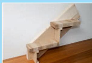
7 Askelma liimataan ja kiinnitetään ruuveilla päälle.
