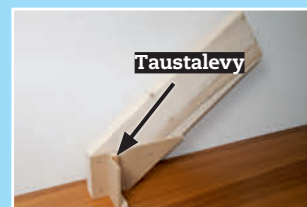
3 Taustalevyt kiinnitetään listoihin etupuolelta.
