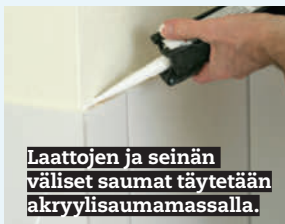
Akryylisauma silotetaan kostealla sienellä tai siveltimellä.
