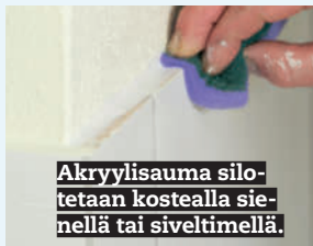
Laattojen ja seinän väliset saumat täytetään akryylisaumamassalla.
