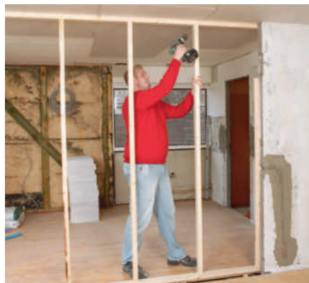
Harkot kiinnitetään runkoon 5 x 100 mm ruuveilla.
