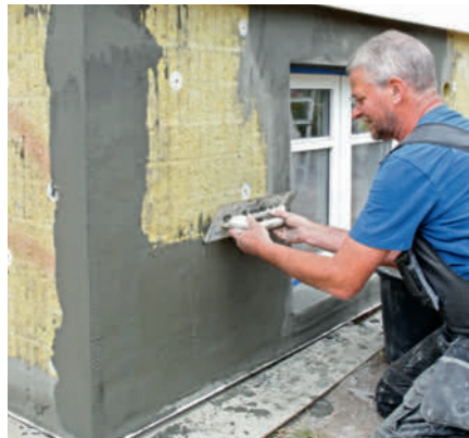
Kulmia vahvistetaan viistoon asetetulla verkolla.
