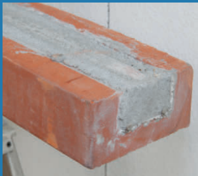
Tiilipalkkiin on valettu kaksi raudoitusterästä vahvikkeeksi.
