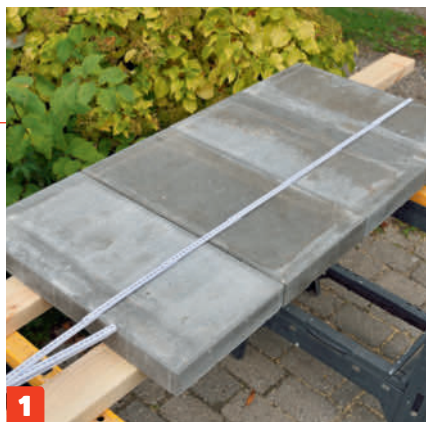
1 Asettele laatat vierekkäin, tarkista mitat ja tee osat laattojen yhteismitan mukaan.
