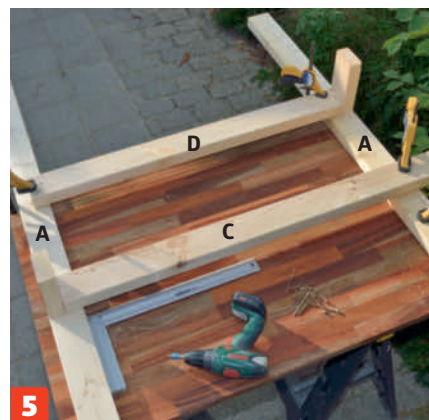
5 Ota pöydän takareunan osat esille. Kokoa ne etureunan tapaan 5x80 millin ruuveilla. Varmista, että takasivuun jää tarpeeksi tilaa poikkilautoille (G).
