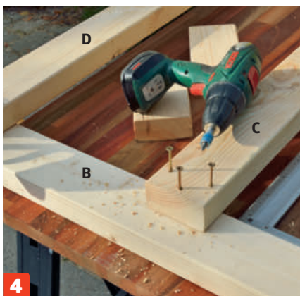
4 Kiinnitä alareunan pitkä sivu (C) ja yläreunan pitkä sivu (D) jalkoihin (B) 5x80 millin ruuveilla. Käytä kolme ruuvia joka liitokseen.
