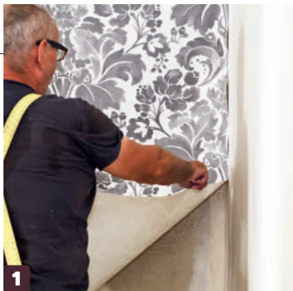
1 Tapetseraren viker tapeten i hörnet, så att han får cirka 2 cm tapet att arbeta med på den högra sidan av hörnet.
