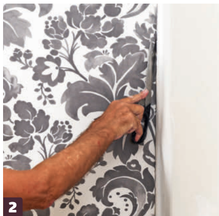
2 Med saxen pressar tapetseraren i tapeten hela vägen in i hörnet. Ta det försiktigt så att du inte råkar skära i tapeten, eller repa den.
