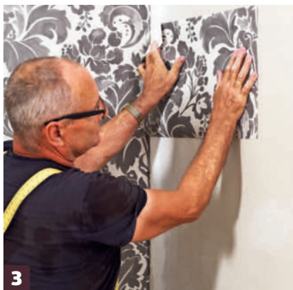
3 Han använder en bit avskuren tapet till att mäta upp med. Få mönstret att passa så bra som möjligt. Det kommer att bli ett litet överlapp, men det syns inte så tydligt eftersom det är så nära hörnet.
