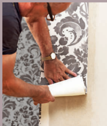
Är det utvändiga hörnet skevt , måste du skära och klippa till tapeten igen för att få mönstret att passa. Låt ett par centimeter av tapeten gå runt hörnet, och skär till nästa våd så att mönstret passar ihop.
