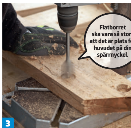
3 Bultar och muttrar försänks med ett flatborr. Centrumspetsen passar i de förborrade hålen. När försänkningen är gjord på bägge sidor av fogningen, borras alla hålen upp med ett 10-mm borr.
