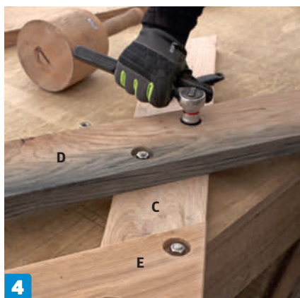
4 A-ramarna monteras med 10 x 60 mm bultar, muttrar och brickor. Innan dess ska alla kanter hyvlas till, och alla ytor slipas med en bandslipmaskin.
