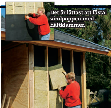
Spikreglarna skruvas fast med 5 x 120 mm skruvar. Man märker genom vindpappen var reglarna finns.
