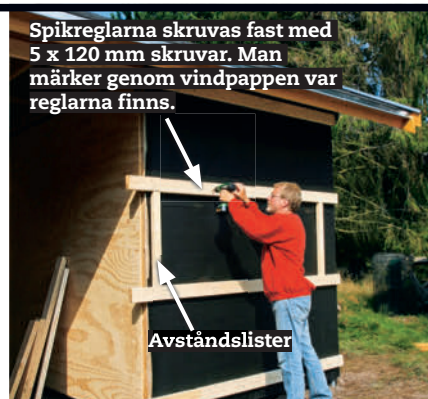
Det är lättast att fästa vindpappen med häftklammer.
