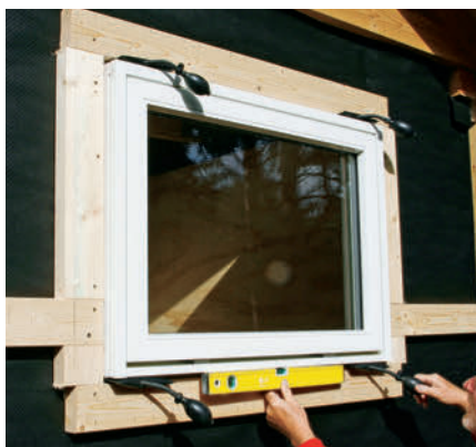
Reglarna runt dörrar och fönster monteras med 5 x 120 mm skruvar.
