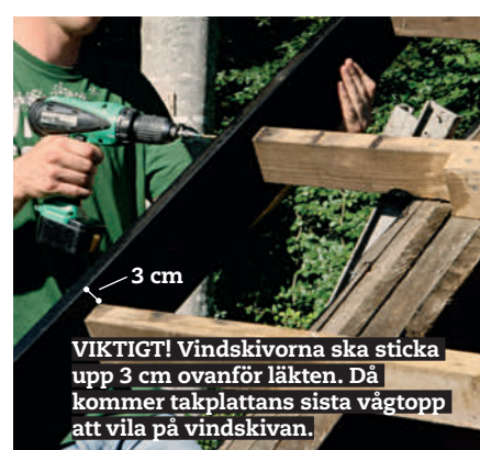
Avsätt vinkeln på vinds kivorna och såga till dessa, så att de passar ihop där de möts. Stryk brädorna med träskydd innan du sätter upp dem.
