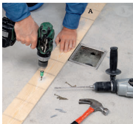
Ta bort listan A, montera listan C vinkelrätt mot plattorna och fyll fältet 3.
