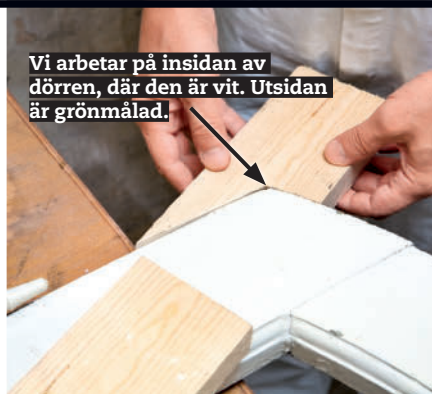
Limma och skruva fast hörnklossarna på brädorna.
