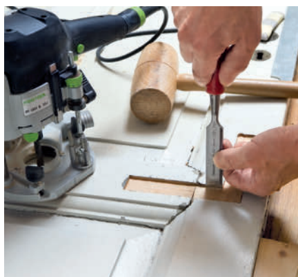
Hörnjärnen knackas ner och skruvas fast.
