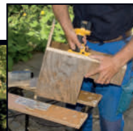
Ingångshålet borrar från båda sidor för att få släta kanter.
