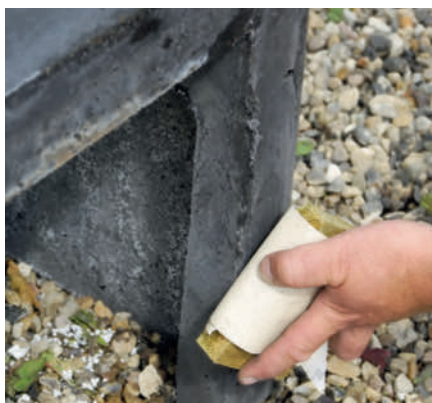
4 Slipa alla kanter och ojämnheter med grovt slippapper så att kanterna fasas en aning och små klickar eller "knoppar" av betong försvinner.
