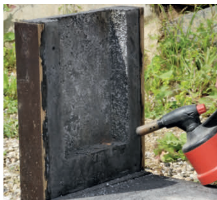
3 De sista resterna bränns väck med blåslampa. Den bränner bort polystyrenen och även den fiber som ev. sticker ut ur betongen, och som du kan sticka dig på. Bränn därför hela bänken.
