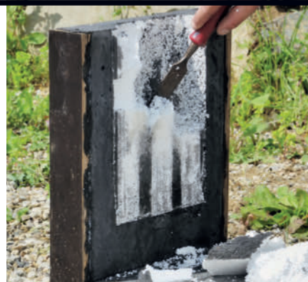
2 Skrapa bort polystyrenen från betongen. Du får bort det mesta med ett kasserat stämjärn.
