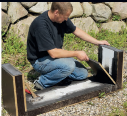
1 Lossa skruvarna och dela formen. Men det ska du göra först efter en vecka, gärna cirka 10 dagar.
