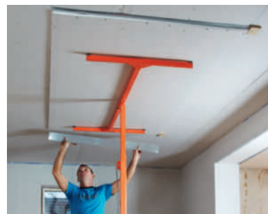
Verktyg: Skivlyften hjälper dig enormt och är billig att hyra. Tack vare den kan du ensam få upp gipsskivorna till taket och fästa dem.
