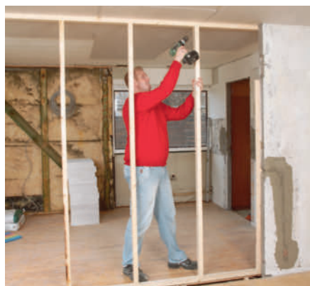
Lättbetongblocken fästs på regelstommen med 5 x 100 mm skruvar.
