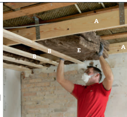
På sina ställen får vi plats för dubbla isoleringsskivor.
