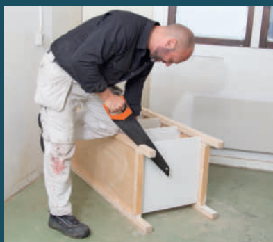
Benen sågas av från det gamla skåpet. Det ska återanvändas men inte på golvet.
