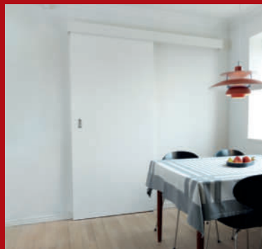
Den enklaste lösningen är att låta skjutdörren glida utanpå väggen.
