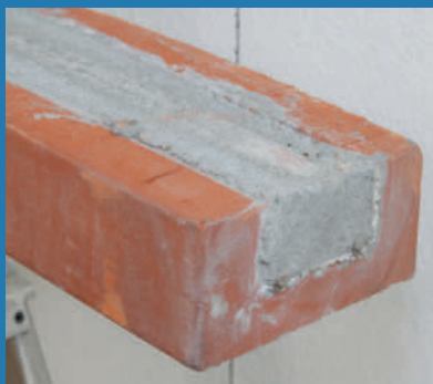
Det ligger två armeringsjärn och betong i spåret för att ge tegelbalken styrka.
