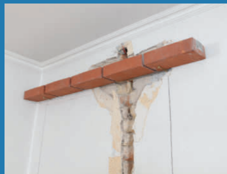
Du kan läsa mera på vår webbplats om hur man lägger tegelbalkar på plats: www.gds.se
