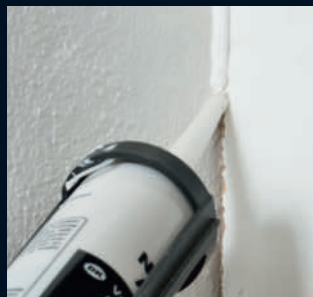
Springan mellan passbitar och vägg fylls med akrylfogmassa.
