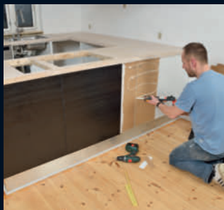
Den synliga baksidan av skåpen kläs med skåpdörrar.
