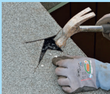
Pressa ner flikarna och fäst dem med pappspikar.
