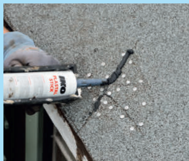
Lägg tjocka strängar med takkitt över alla pappspikar och skarvar.
