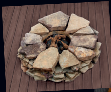
Här ser du en bålplats av platta stenar som har limmats ihop med eldfast bruk. Då skyddas träet mot eldens värme.
